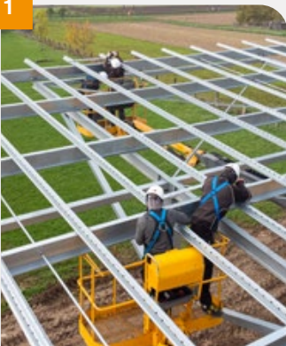
Mise en place des rails Soprasolar® Park .
