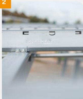
Fixation des rails Soprasolar® Park aux pannes par crapauds.
