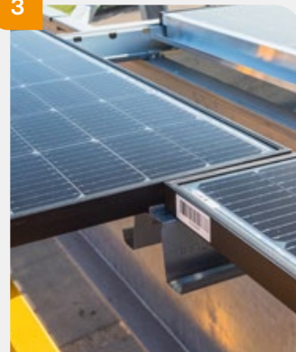
Pose des modules sur les rails.
